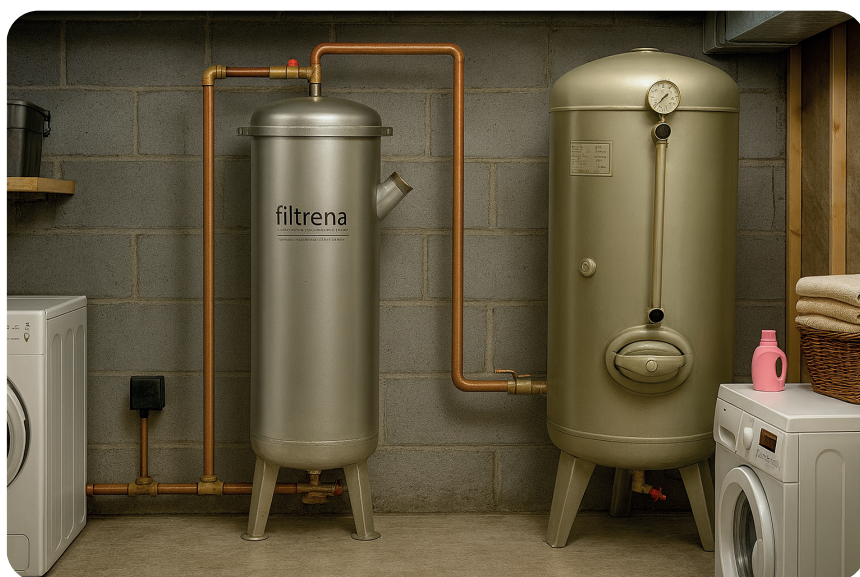
Exempel på installation
