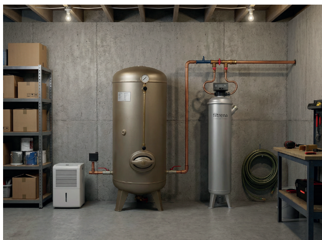
Exempel på installation Mandio mot hydrofor
