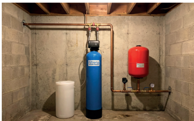
Exempel på installation. Multi 10-40
