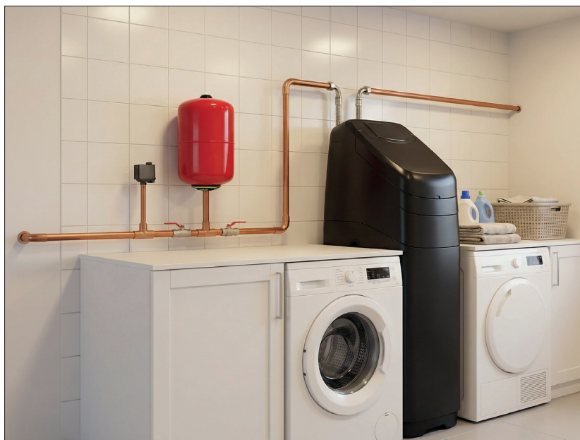
Exempel på installation
