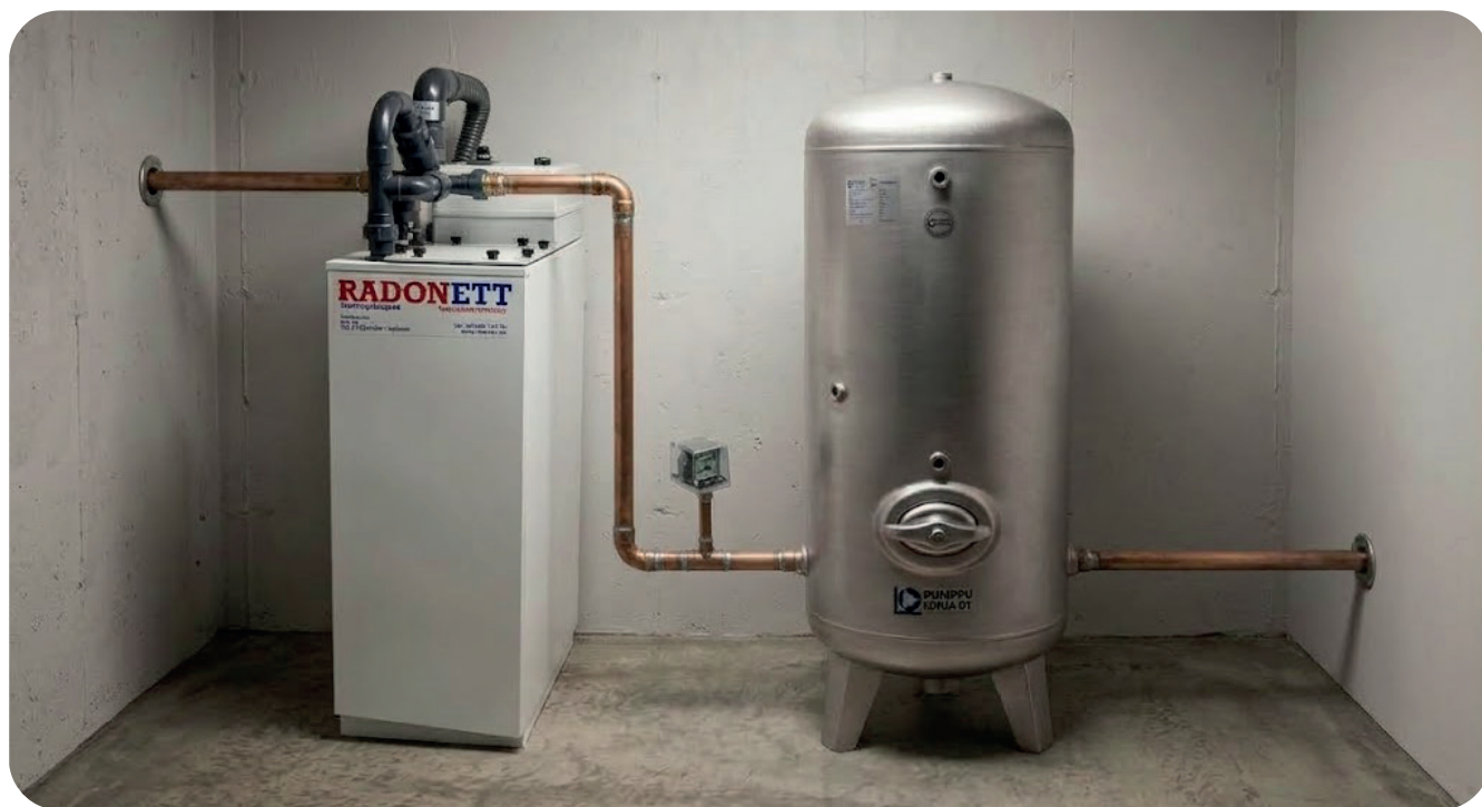
Exempel på installation
