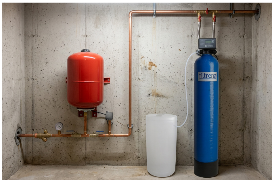
Exempel på installation
