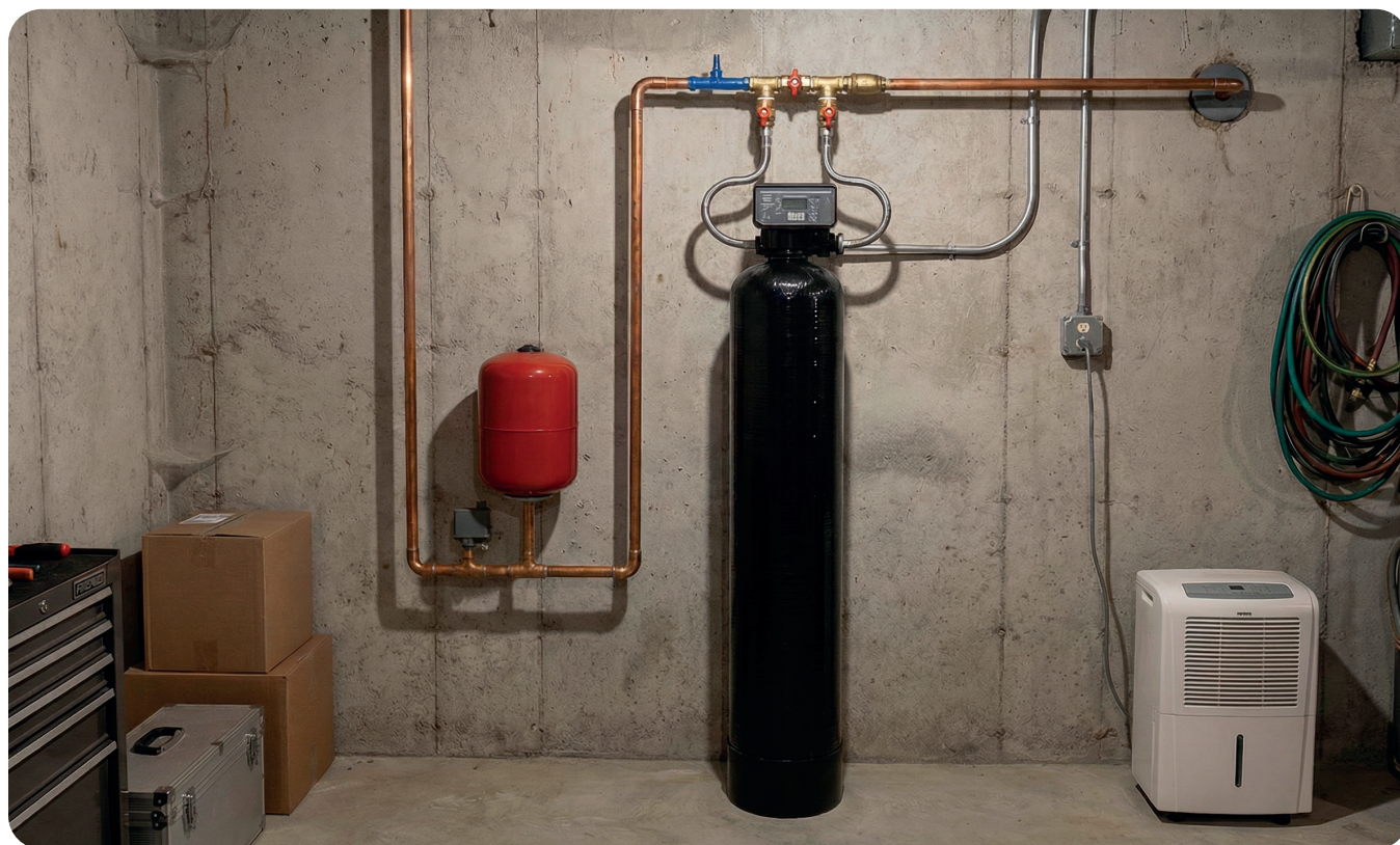
Exempel på installation
