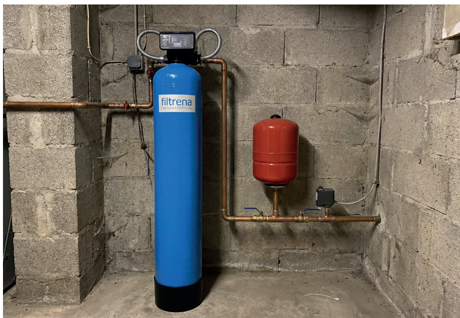
Exempel på installation
