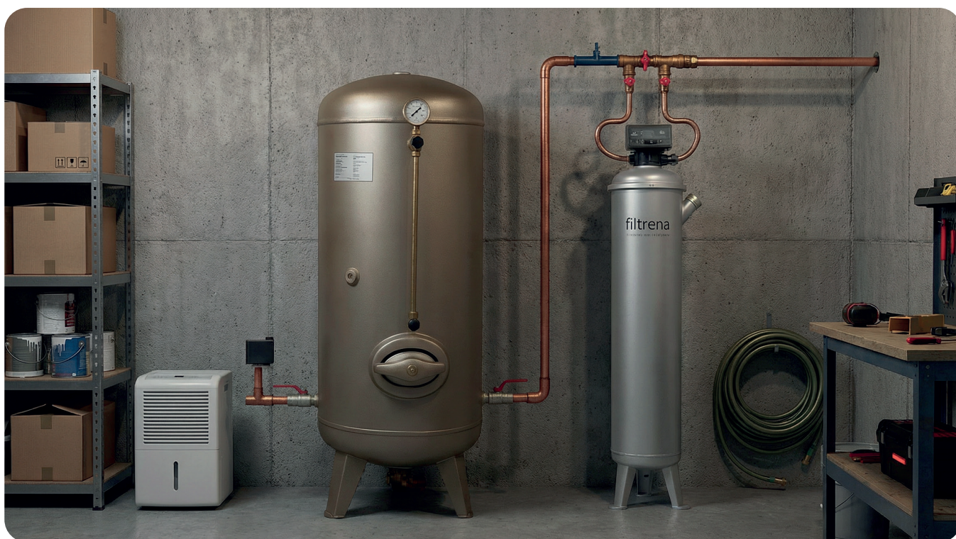
Exempel på installation
