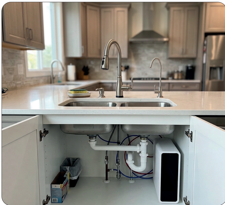
Exempel på installation
