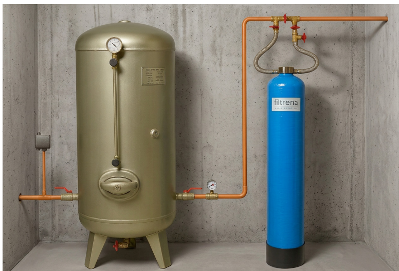
Exempel på installation
