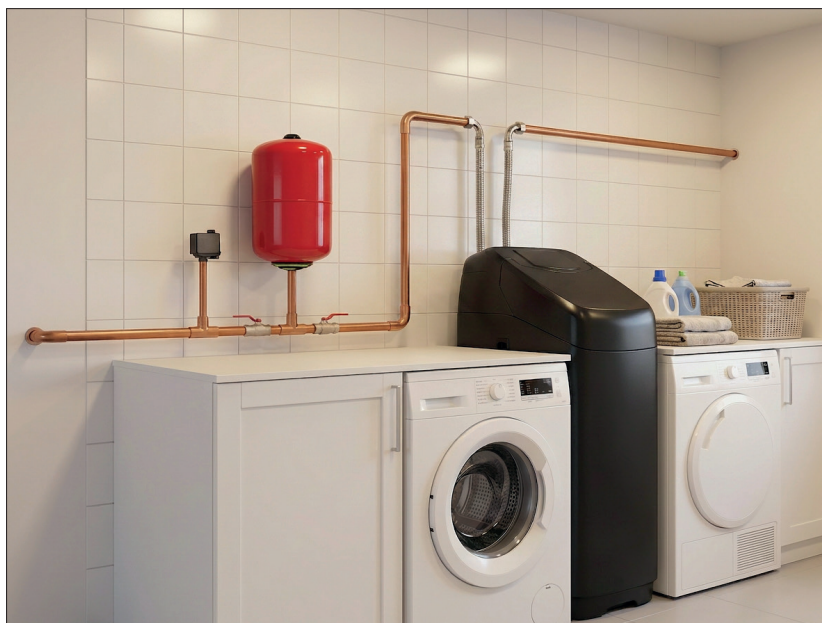
Exempel på installation
