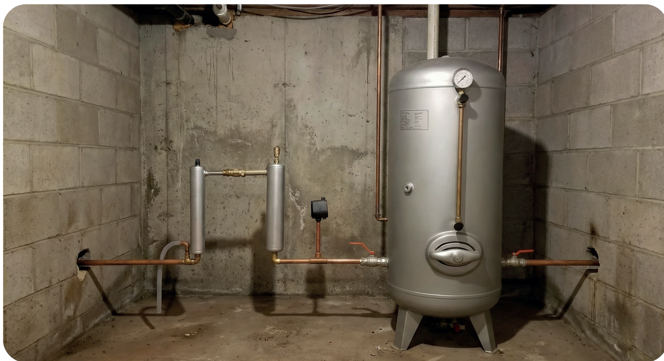
Exempel på installation
