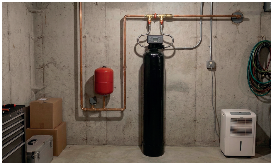
Exempel på installation
