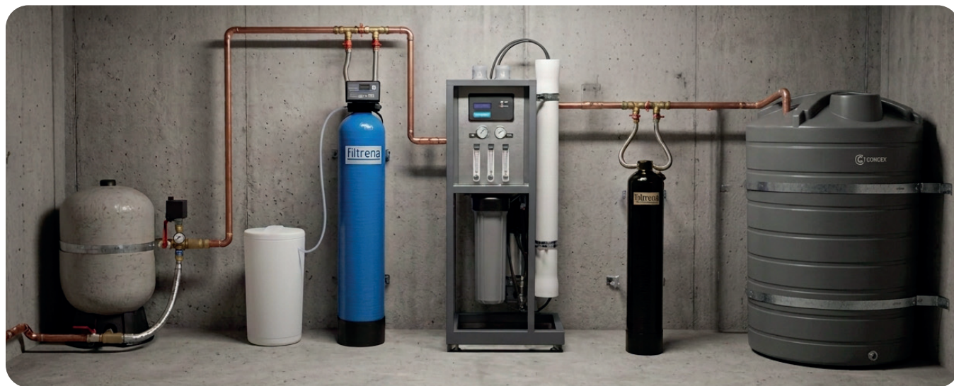
Exempel på installation
