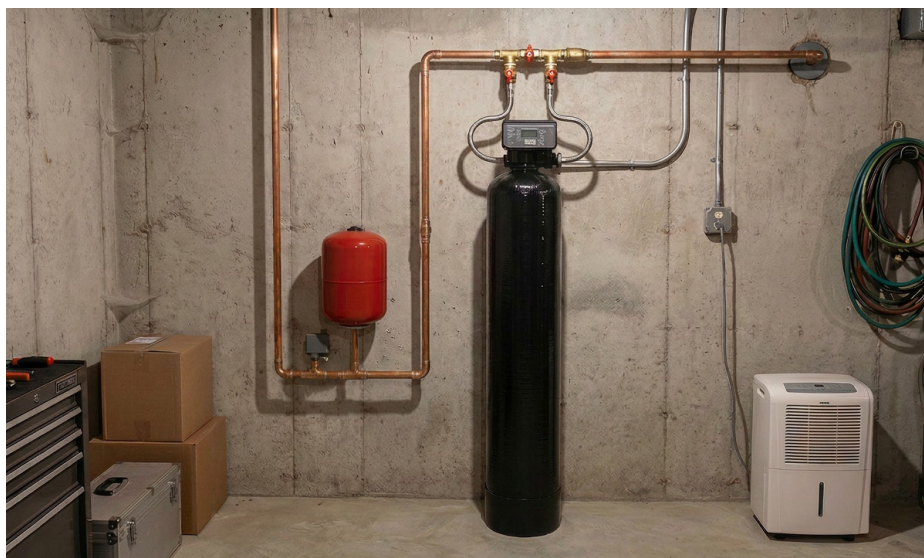
Exempel på installation
