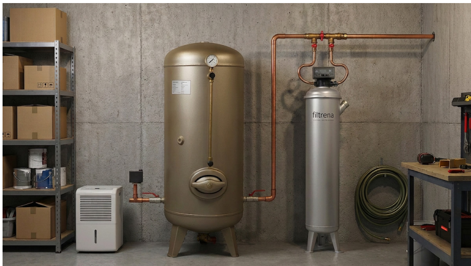
Exempel på installation
